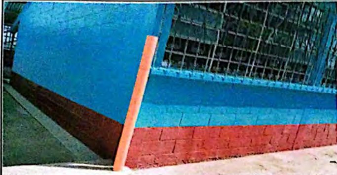
Pintura de muros exteriores e interiores
