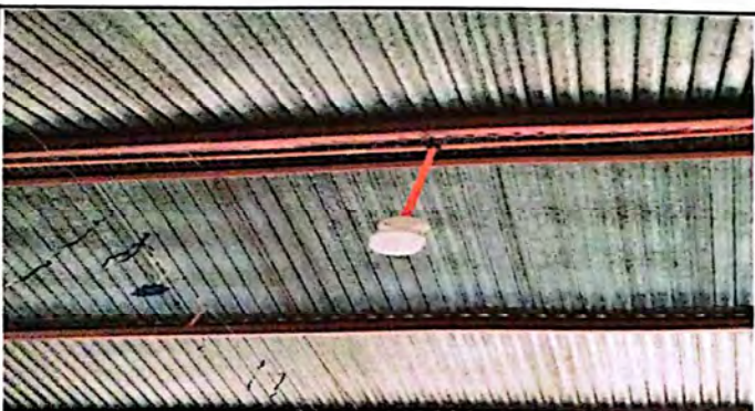
Reparacion de sisema electrico ( cable, focos, ducto electrico y accesorios)
