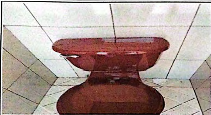
Sustitucion de inodoro
