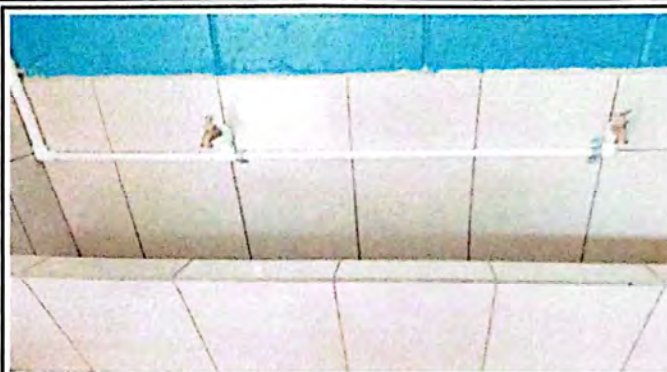
Sustitucion de azulejo
