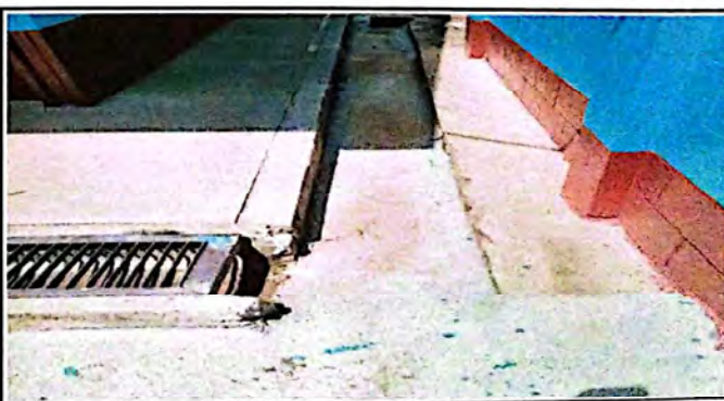
Reparacion de red de agua potable
