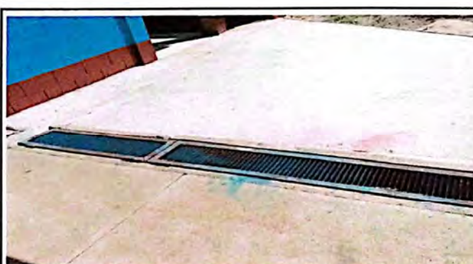
Mejoramiento de plancha de concreto de patio.
