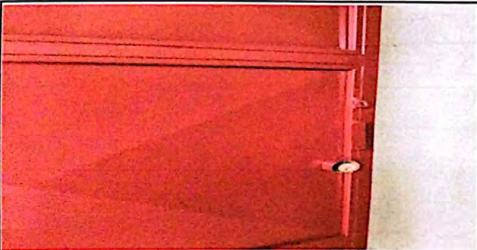
Mantenimiento de estructura de puerta de metal
