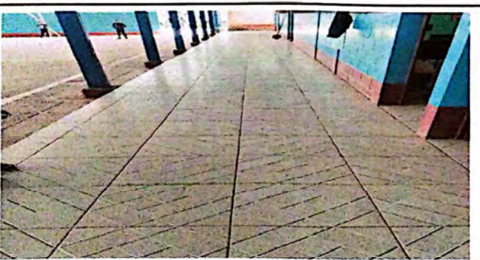
Sustitucion de piso ceramico
